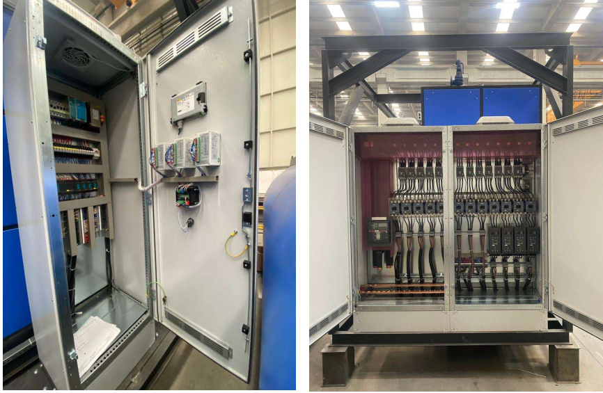
Resim 21: Örnek Elektrikli Kazan Kontrol ve Güç Panoları
